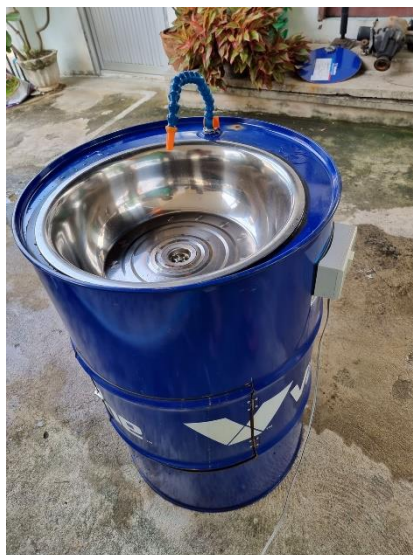
ภาพที่ 3.7 แสดงการติดตั้งก๊อกรน้ำ
